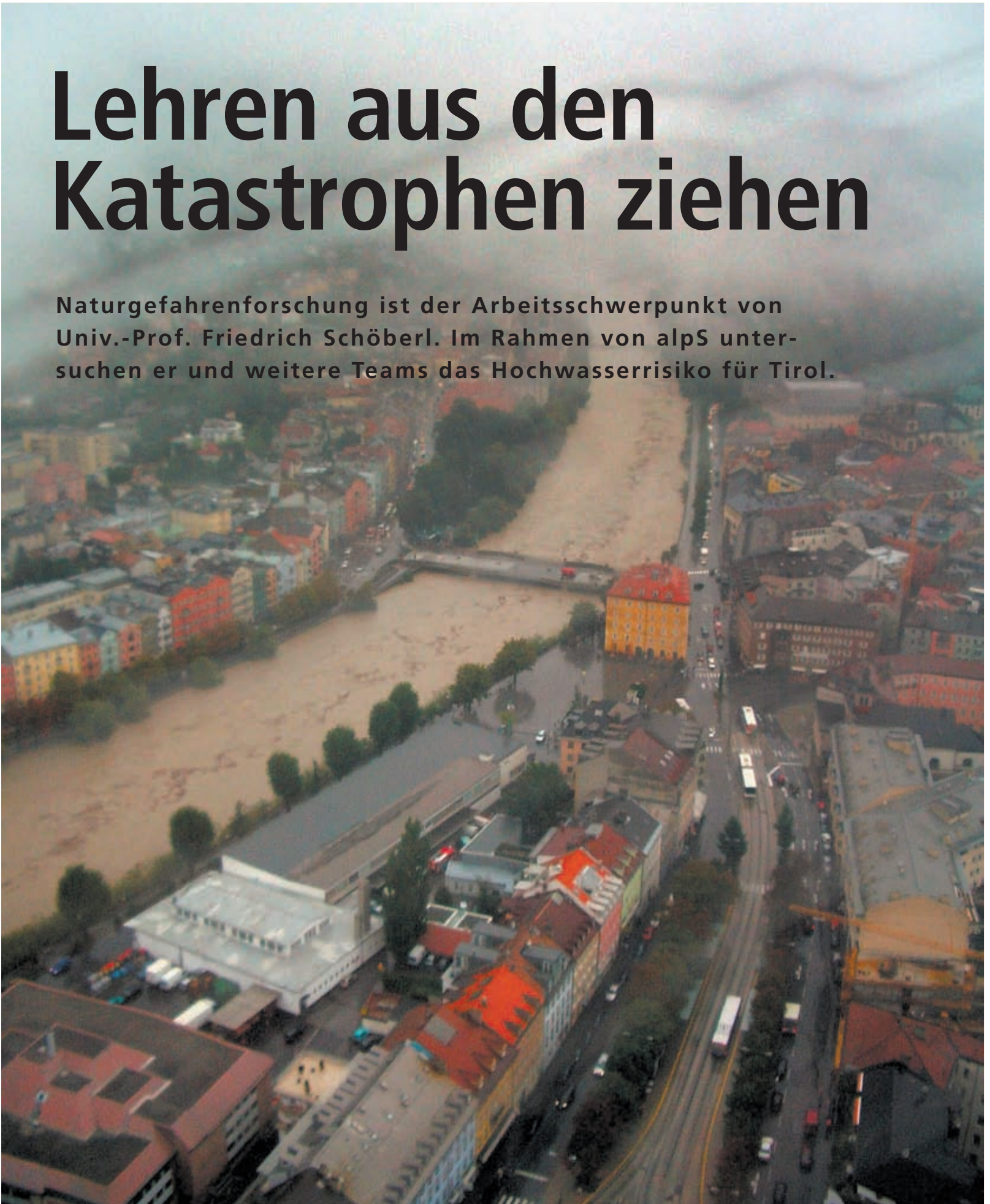
Blick auf die Innbrücke in Innsbruck während des Hochwassers im Sommer 2005.
