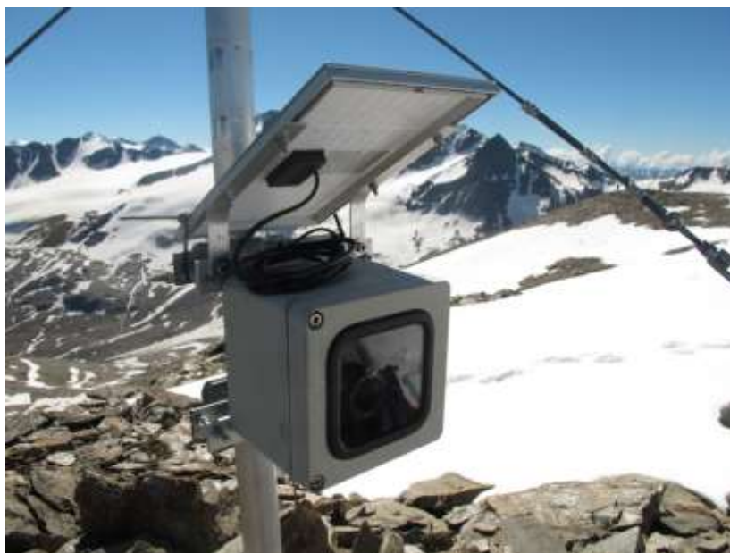
Abbildung 32: Die automatische Kamera am Rofenberg nach Reparatur des Solarpanels und des Gehäuses. Foto: Rainer Prinz, 18.07.2014.
