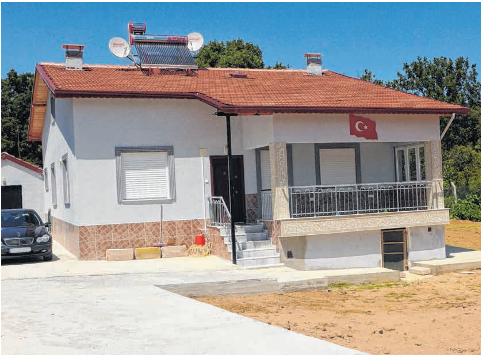
Haus eines Rückkehrers in Yeniceköy nach Tiroler Bauart.
