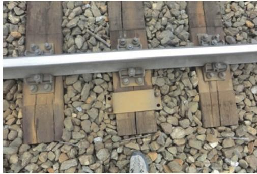
**Abbildung 13: Oberbaumangel - Sicherungskappe mit lockeren bzw. fehlenden Schrauben**
