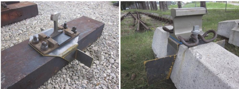
Abbildung 118: SIK Ohrensattel auf Holz und Betonschwelle, Foto: [48]
