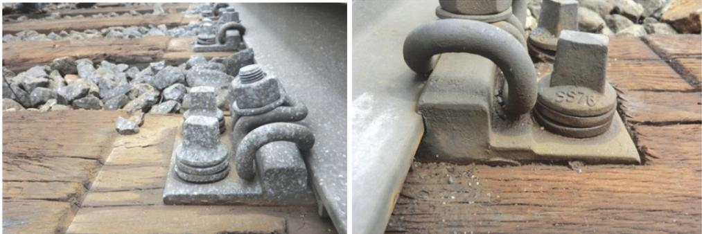
**Abbildung 121: Eingearbeitete Schiene in der Rippenplatte**
