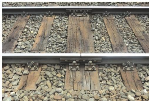
**Abbildung 14: Oberbaumangel - Stoßlückengleis mit zwei verschiedenen Rippenplatten**
