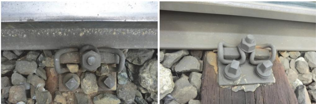
**Abbildung 122: Spannklemmen mit geringer Sicherheitsreserve und geklebte Rph**
