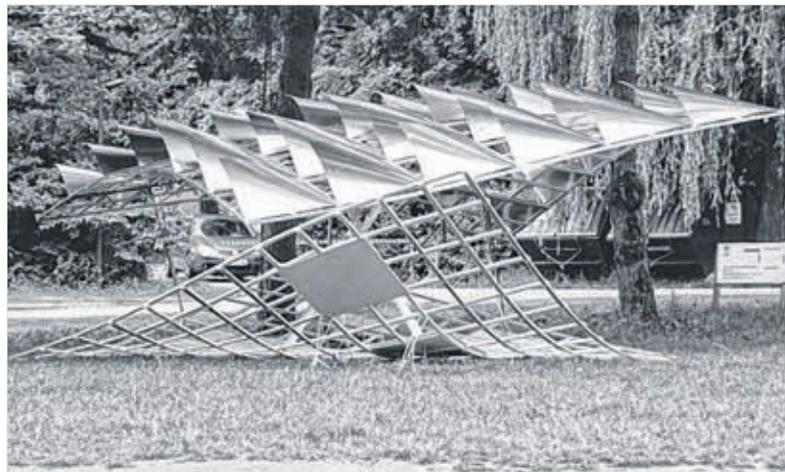
**„Biegeaktive“ Experimente: Der Versuchsbau „[loops]“ zeigt Formvarianten eines 8 mm dünnen Sperrholzstreifens (links), bei „[2Landscapes]“ sperren sich zwei Landschaften aus extrem dünnen Holzplatten und Alublechen selbst und ergeben ein stabiles Gebilde.**
