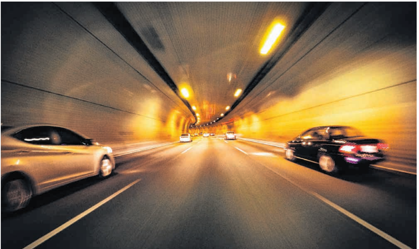
Das Sicherheitsempfinden der Autofahrerinnen und Autofahrer hängt wesentlich von der Beleuchtung im Tunnel ab.
