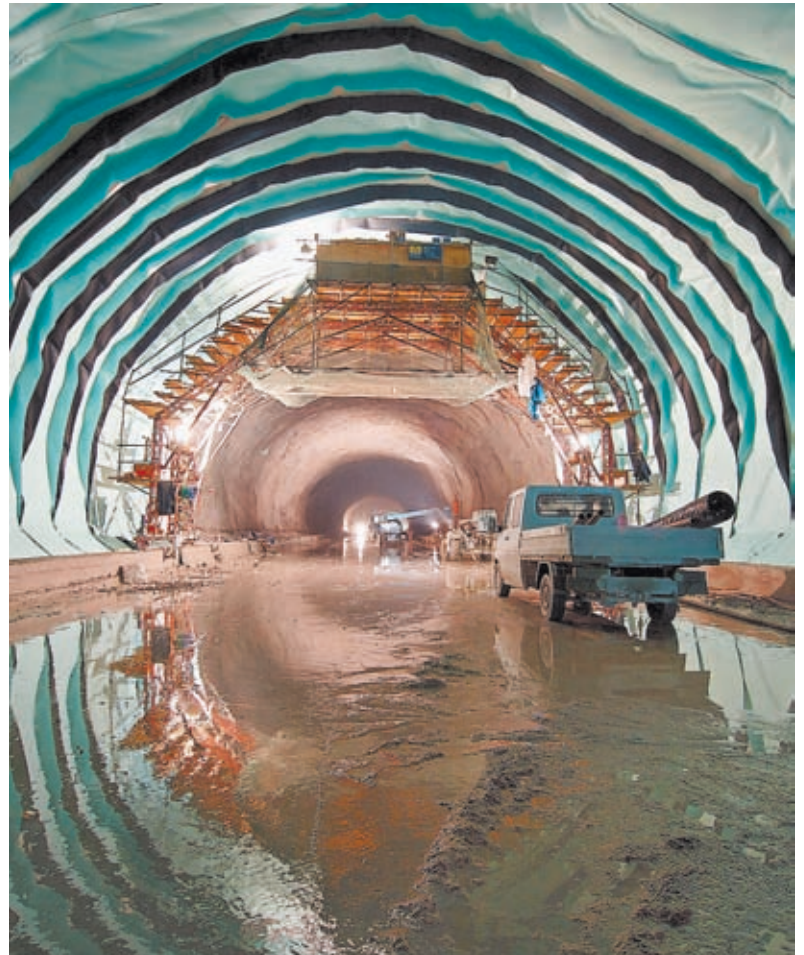
Abdichtungsarbeiten im Haupttunnel.
