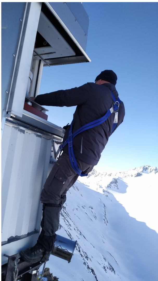
Abbildung 34: Anzeichnen der Schliffkanten zur Minimierung der Reibung der Fenster. Foto: Rainer Prinz, 24.02.2021.
