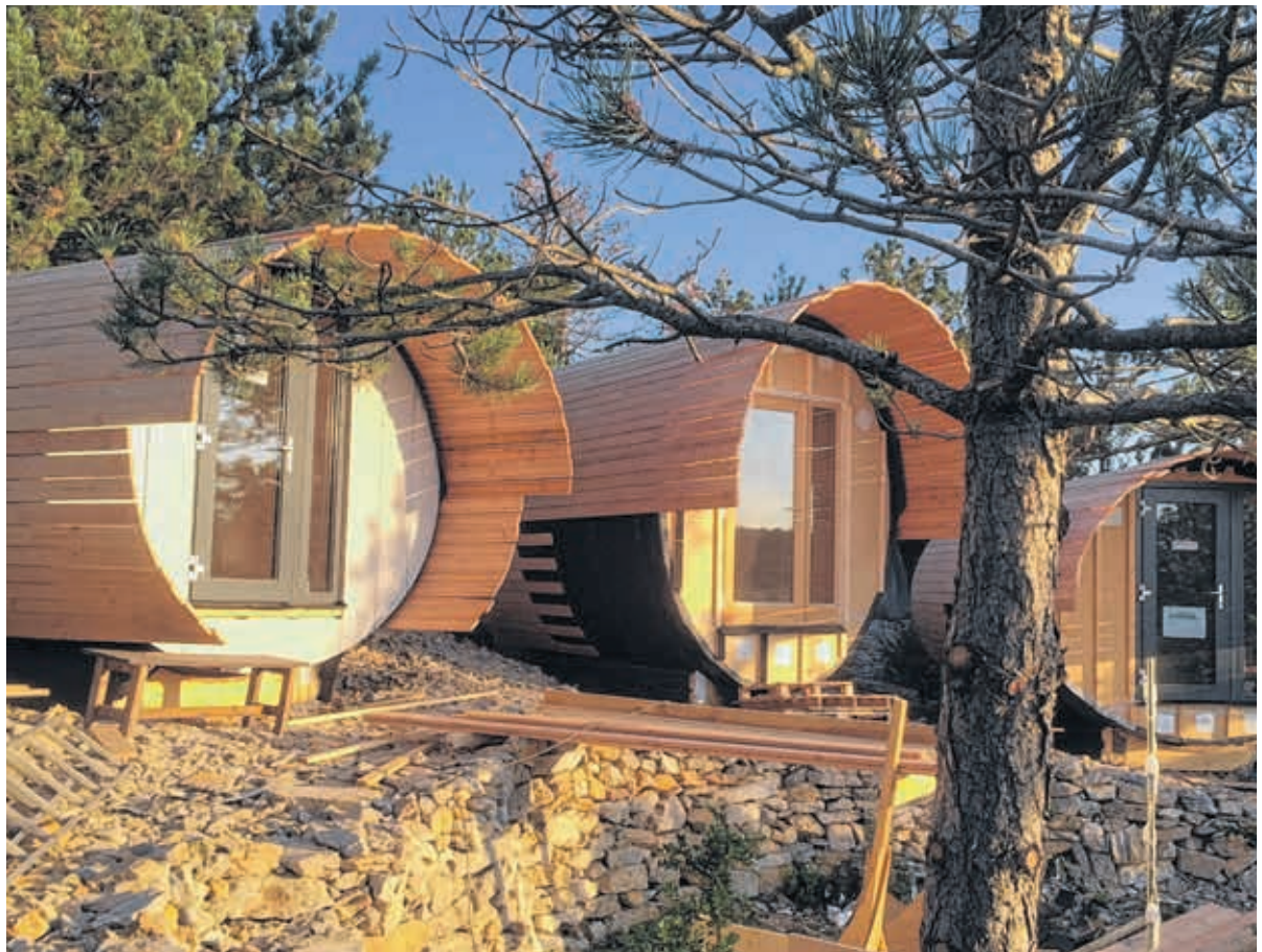
Zwei liegende und eine stehende Ellipse bilden ein Ensemble. Auch die Trockenmauer vor den Holzbauten haben die Studierenden selbst gebaut.
