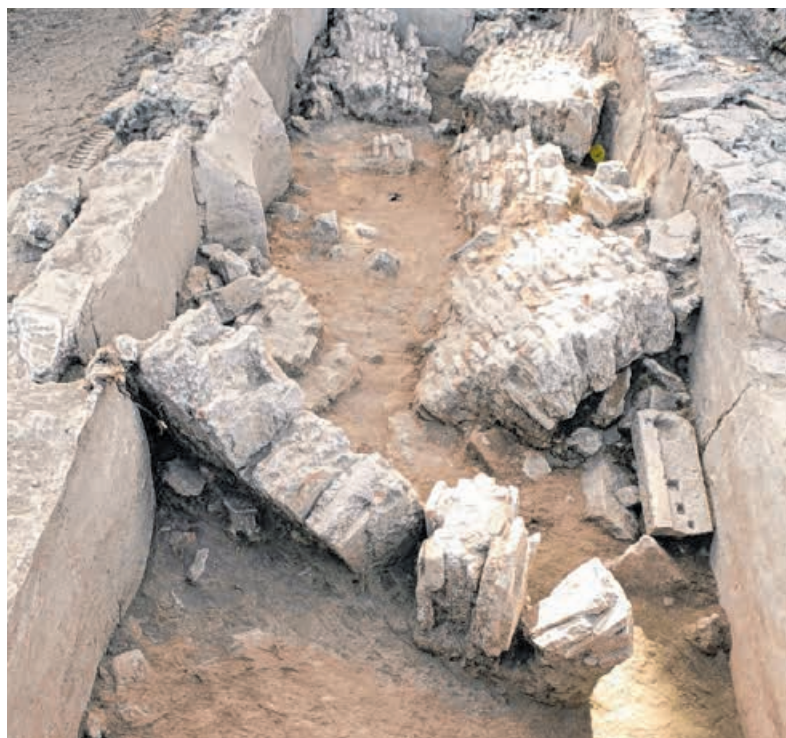
Das Wasserdepot mit darin liegenden verstürzten Gewölbeteilen während der Grabung.
