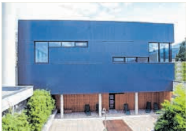
Die neue Mehrzweckhalle des Universitätsinstituts. Foto: Helmut Weichselbaumer
