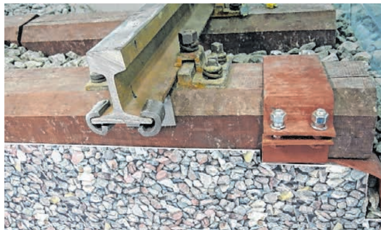
Sicherungskappen erhöhen den Querverschiebewiderstand einer Schwelle.
