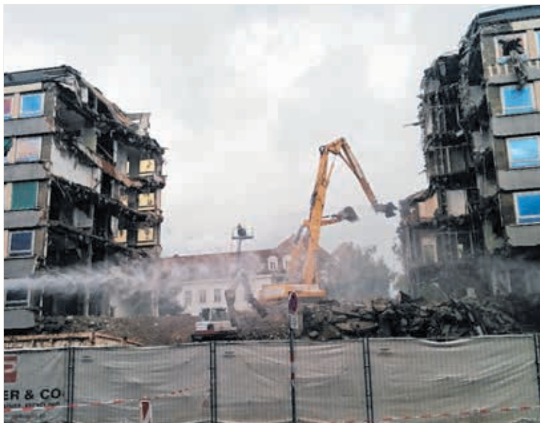
Am 24. August startete offiziell der Abbruch der „Alten Chemie“. Foto: Hofer
