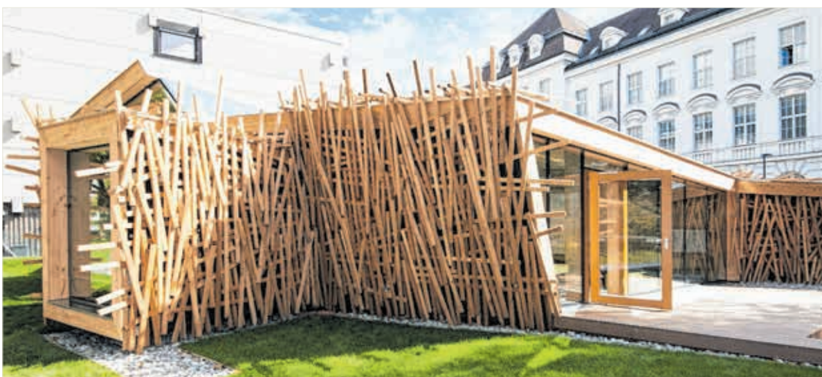
Die außergewöhnliche Fassade erinnert an ein Vogelnest: Holz ist für den gesamten Bau das wichtigste Material.
