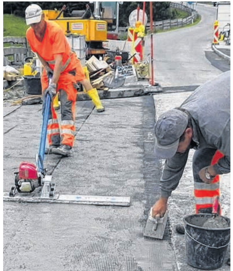
Arbeiten am Pilotprojekt: Die textile Bewehrung wird vorsichtig einge-rüttelt.
