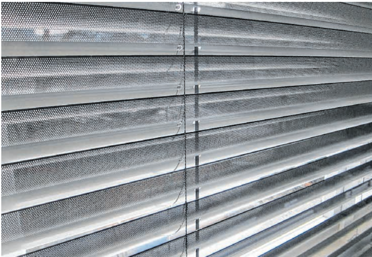
Lichtlenkungslamellen lenken das Tageslicht an die Decke. So kann blendfrei gearbeitet werden und der Kunstlichtbedarf wird reduziert.
