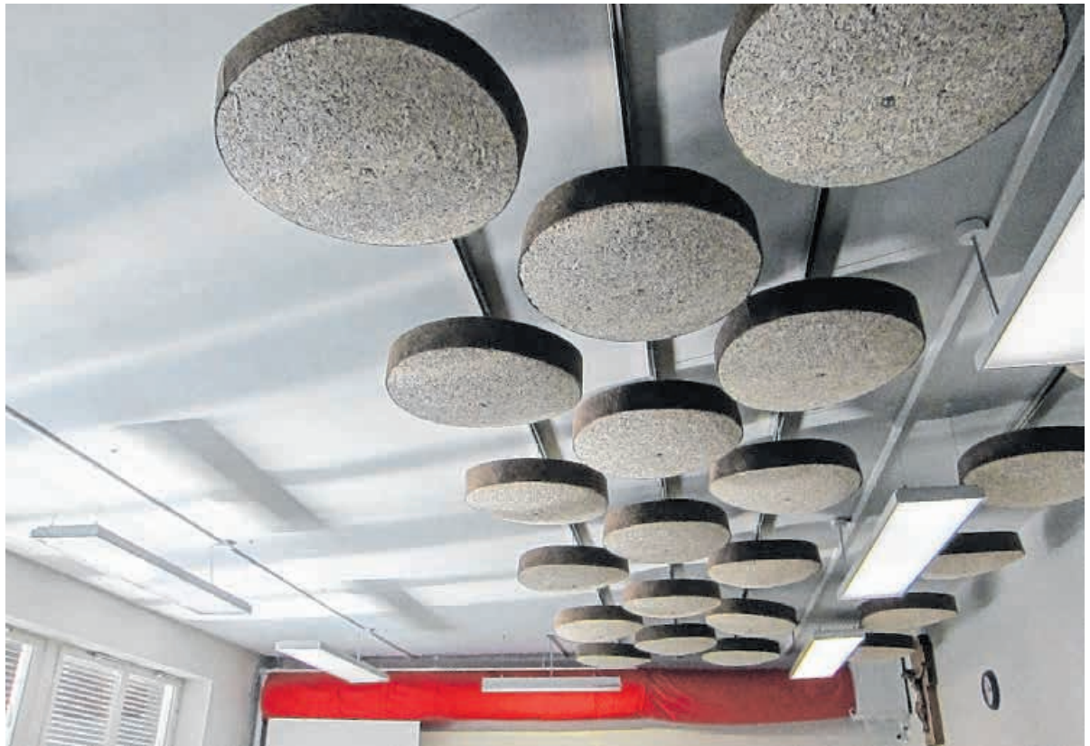
In der NMS Hötting setzt man auf Tageslicht: Lichtlenkungslamellen bingen das Tageslicht tief in den Raum. Mit dem DALEC-Tool lassen sich die Lichtverhältnisse schon vorher berechnen.
