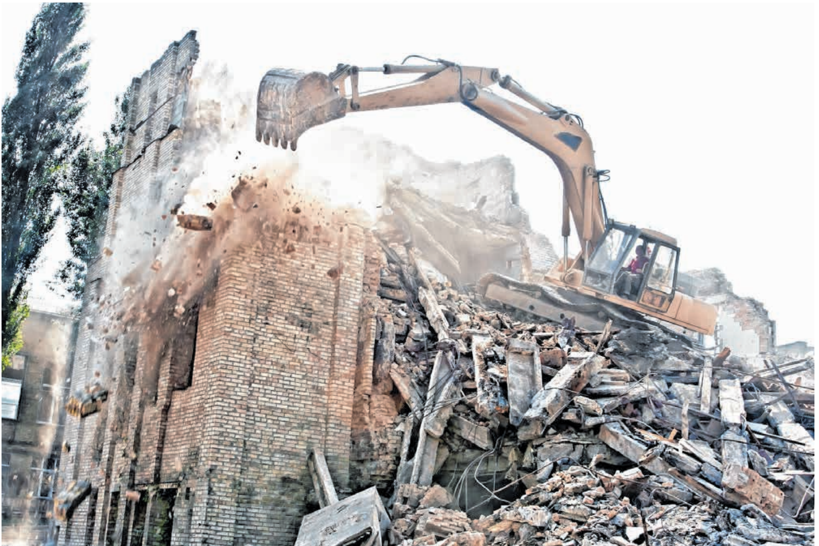
Aus Schrott wird Wertvolles: Bei sorgfältiger Trennung können aus Abbruchstätten viele verschiedene Rohstoffe entnommen und wiederverwendet werden.
