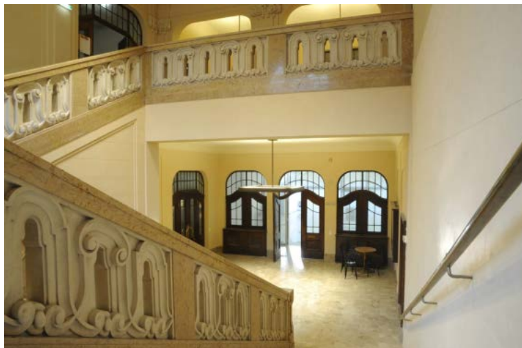
Bild: Das renovierte Stiegenhaus
