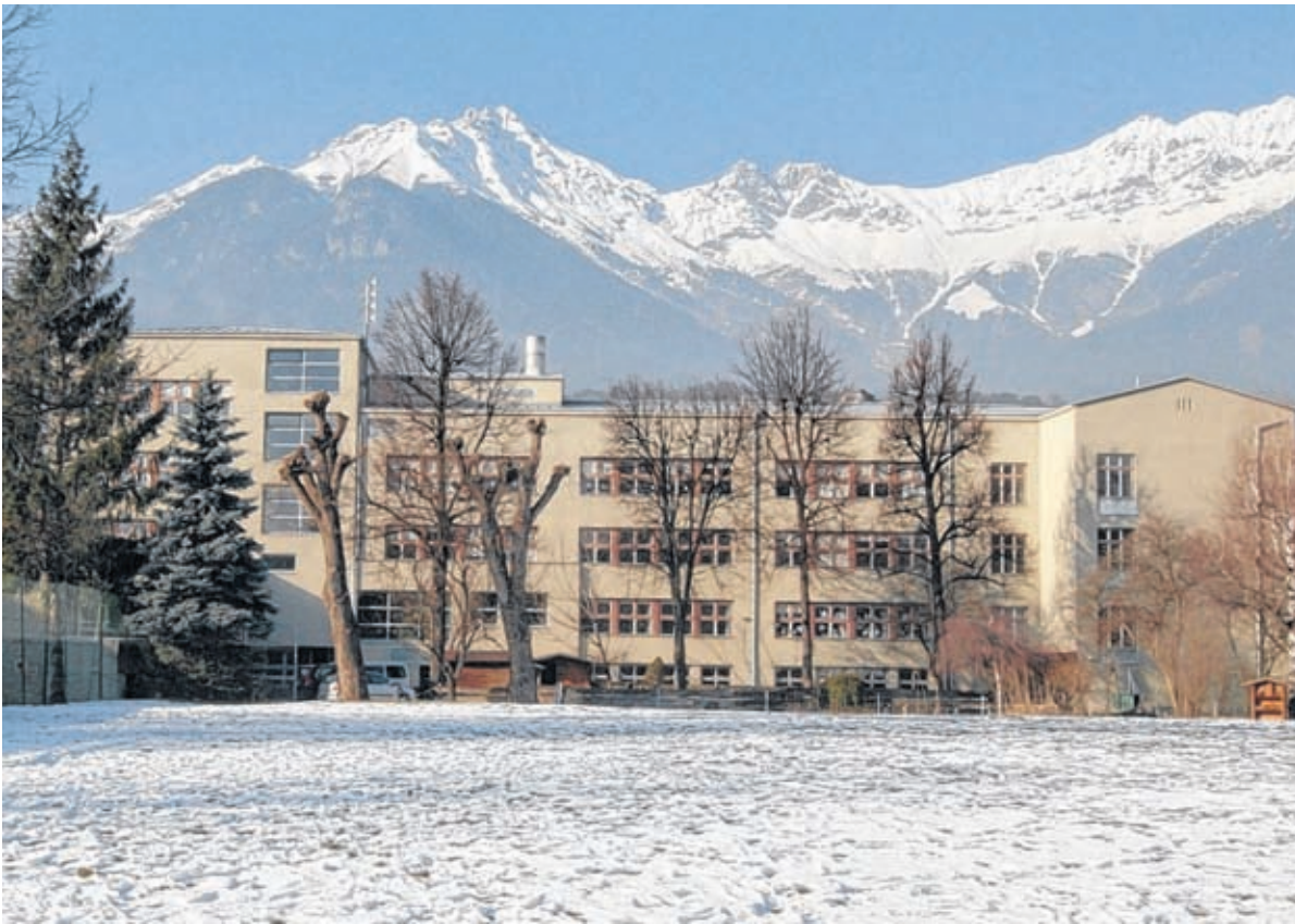
Die Neue Mittelschule Hötting stammt aus den dreißiger Jahren. Da sie dem Denkmalschutz unterliegt, müssen bei ihrer Sanierung zahlreiche Auflagen beachtet werden. Fotos: Institut für Konstruktion und Materialwissenschaften
