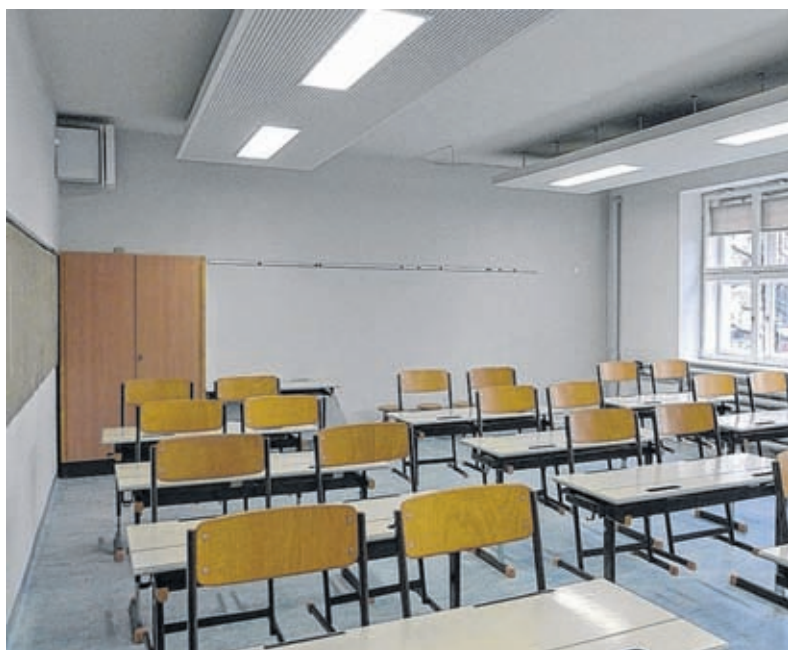
Ein Blick in die Musterklassen: Beide Räume erhielten unterschiedliche Systeme zur Schalldämpfung. Links ein klassischer gelochter Gipskarton, rechts ein Absorber aus organischem Material. Rechts auch gut zu sehen ist der rote Textilschlauch, der die Luft in den Raum transportiert.
