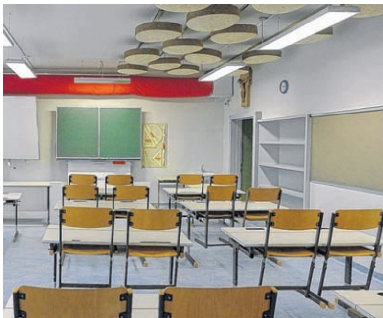
Ein Blick in die Musterklassen: Beide Räume erhielten unterschiedliche Systeme zur Schalldämpfung. Links ein klassischer gelochter Gipskarton, rechts ein Absorber aus organischem Material. Rechts auch gut zu sehen ist der rote Textilschlauch, der die Luft in den Raum transportiert.
