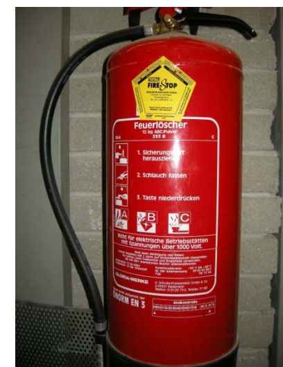
6 kg Pulver-Löscher feste Brandstoffe, brennbare Flüssigkeiten, brennbare Gase
