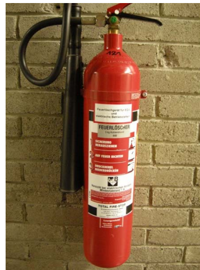
5 kg CO 2 -Löscher für elektrische Anlagen und EDV
