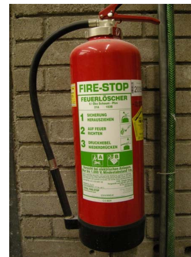
6 kg Schaum-Löscher feste Brandstoffe, brennbare Flüssigkeiten
