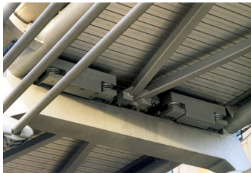
Abbildung 1.1: Schwingungstilger an der Millennium Bridge [GK].
