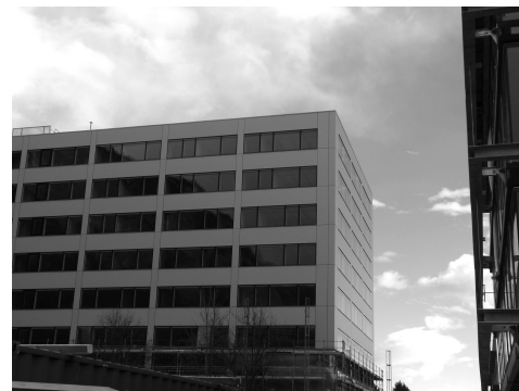
Campus Technik Bauingenieurgebäude Fotos: VR für Infrastruktur
