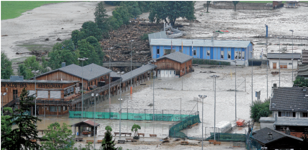
Klosters (Graubünden/Schweiz): ausgedehnter Wasserübertritt durch Verklauung (Schwemmbolz), Hochwasser August 2005 (Quelle: Gebäudeversicherung Graubünden /GVG)
