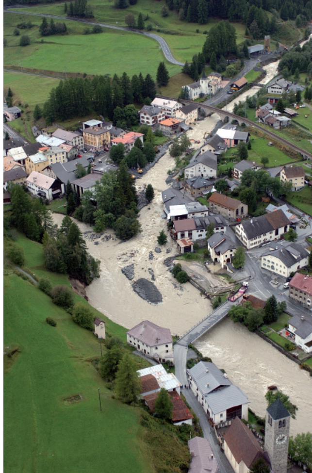
Sasch (Graubünden/Schweiz), Ufererosion im Inn, Hochwasser August 2005 (Quelle: Gebäudeversicherung Graubünden / GVG)
