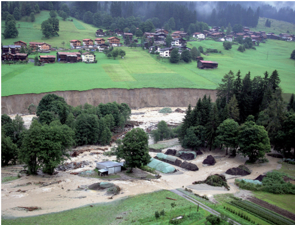
Klosters (Graubünden/Schweiz): die korrigierte Landquart verursacht ausgedehnte Ufererosionen und kehrt streckenweise in ihr ehemaliges Gerinne zurück, Hochwasser 2005 (Quelle: Gebäudeversicherung Graubünden / GVG)
