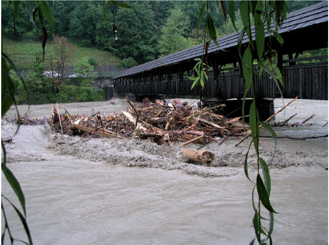
Innsbruck (Tirol/Österreich): Verkläusung im Inn am Psenner-Steg, Hochwasser August 2005 (Quelle: alpS)
