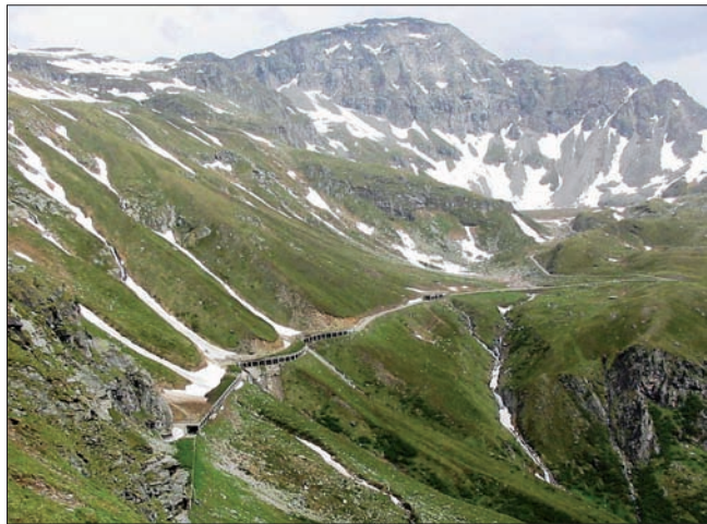
Abb. 11. Eine hohe Grunddisposition für Lawinen besteht auf den steilen grasbewachsenen Hängen der Torleiten oberhalb des Wurtenspeichers. Gefährdet ist in erster Linie die Zufahrtsstraße zum Weißseehaus, die über weite Strecken durch Lawinengalerien gesichert ist.
