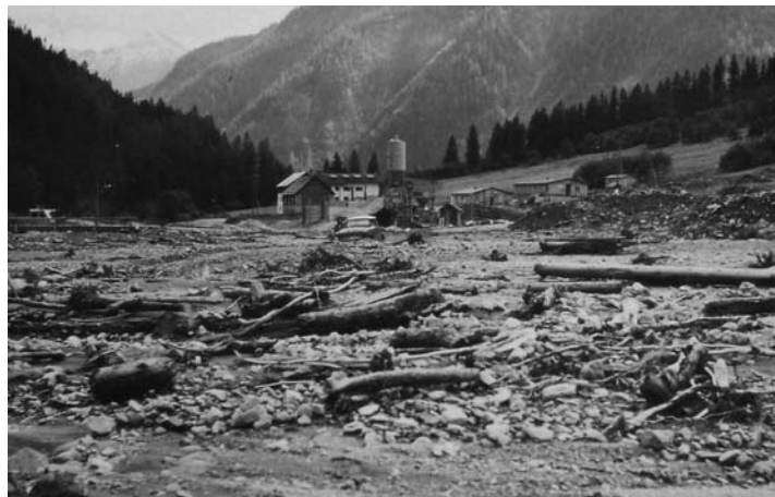
Abb. 14. Auswirkungen des Hochwassers 1965 im Bereich Innerfragant (Foto: Archiv WLV)
