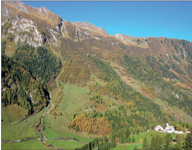
Abb. 12: Der Südostabfall des Schodenkopfs wird von mehreren Lawinenzügen geprägt, von denen die fast jährlich abgehende Schodenkopflawine bis zur Hüttwinklache vordringen kann. Dabei befinden sich auch mehrere Häuser und Höfe im Gefährdungsbereich. Die hohe Grunddisposition für Lawinen ist neben der Hangneigung vor allem durch die Hangexposition bedingt, da es im Kammereich zu bedeutenden Einwehungen aus Nordwesten kommt. Die im Vergleich zum 19. Jahrhundert wesentlich stärkere Bewaldung ist nur bedingt wirksam, da es sich auf großen Flächen um Grünerlengebüsch handelt, das den Lawinen keinen Widerstand entgegensetzen kann.
