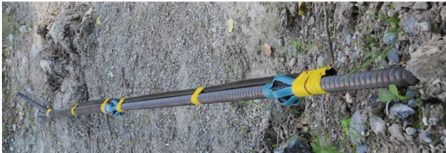
Bild 3, Vorgefertigter Anker mit Schutzrohr, Distanzhalter und Mörtelschlauch
