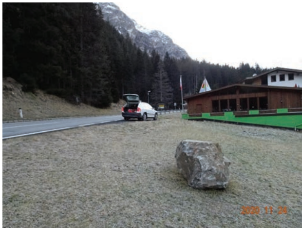
Bild 1, Sturzblock des Ereignisses vom 12.11.2020, der die Landesstraße querte
