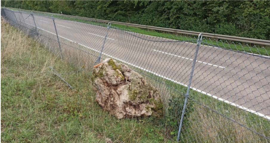
Bild 2, Drahtzaun mit erfolgreich zurückgehaltenem Block mit einer Kubatur von etwa 0,7 \text{ m}^3 .
