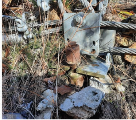
Bild 1, (a) Deformierter Rundstab und vertikal verschobene Grundplatte infolge fehlender Kontermutter (b) Beschädigter Verpresskörper und gelöste Mutter; Korrosionsschutz nicht gewährleistet
