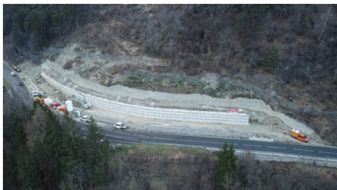
Bild 7, L 76 Landecker Straße, Erdbeben Mure, Sicherung durch Bohrpfehlwand, 2022/2023
