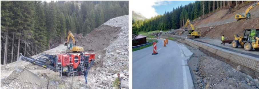
Bild 6, links: Entnahme und Aufbereitung von Schüttmaterial aus einem Geschiebe-Ablagerungsbecken im hinteren Pitztal. Rechts: Schütt- und Verdichtungsarbeiten des bewehrte-Erde Damms
