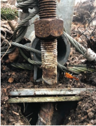
Bild 1, (a) Deformierter Rundstab und vertikal verschobene Grundplatte infolge fehlender Kontermutter (b) Beschädigter Verpresskörper und gelöste Mutter; Korrosionsschutz nicht gewährleistet
