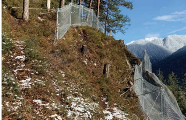
Bild 5, Drahtzäune als Aufständigung der Vernetzung (rechts) und freistehend (links).
