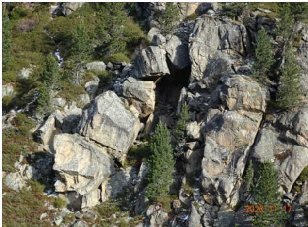
Bild 2, potentiell instabiler Blockstapel ca. 400 Höhenmeter oberhalb des Siedlungsraumes und der Landesstraße am Talboden
