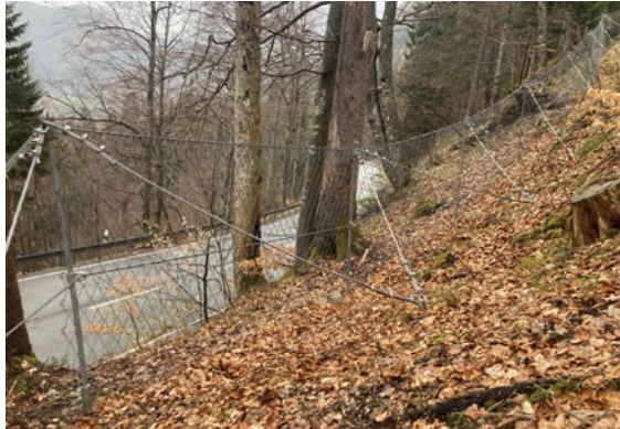
Bild 4, Drahtzaun nach Ausführungsempfehlung der ZIG mit einem bemessenen Energieaufnahmevermögen von 60 kJ.
