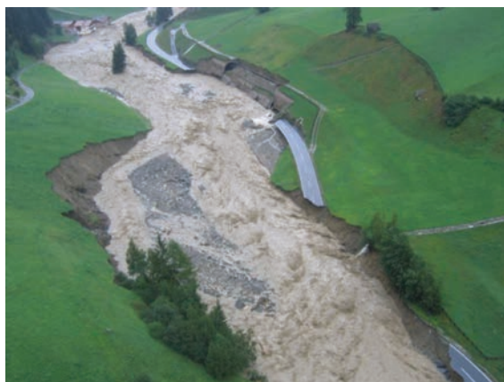
Bild 9, B 188 Paznauntalstraße, Hochwasser 23.08.2005
