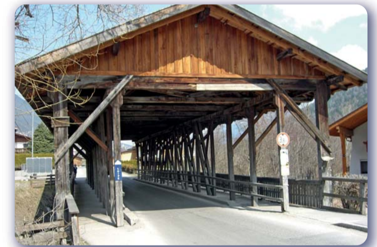
Bestehende Brücke in Fulpmes
