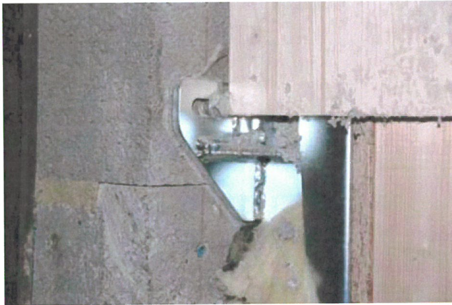
Bild 1: Detailaufnahme bei der Montage - Fassadenverbinder
