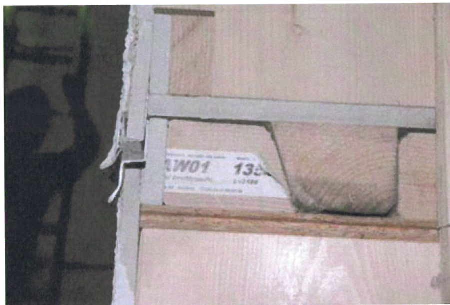
Bild 2: Detailaufnahme während des Aufbaus – Bauteilstoß Horizontalfuge
