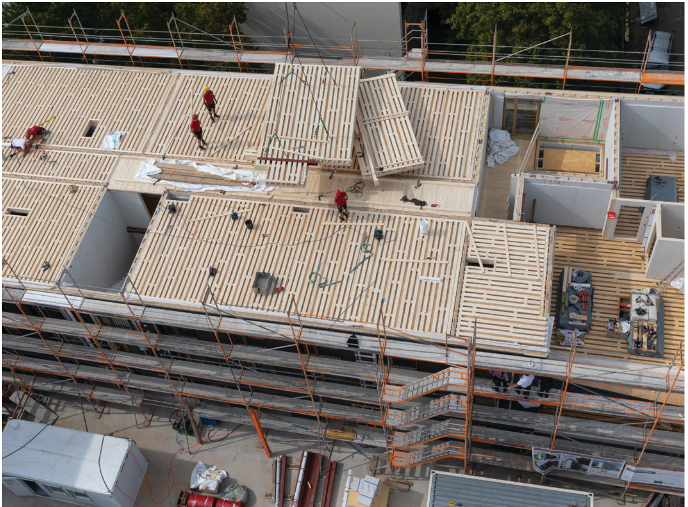
Gebäudeklasse 5 mit Sichtholz: In diesem achtgeschossigen Wohn- und Geschäftsgebäude in Freiburg wurden Brettsperrholz-Rippendecken des Typs Ligno Rippe-x eingesetzt.
