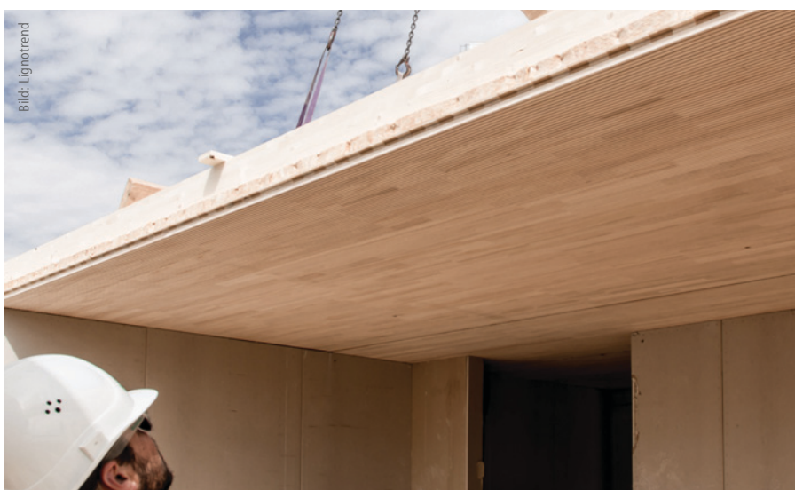
Die abgesperrten Gurtplatten ermöglichen eine hochwertige, gegen Risse resistenterere Sichtqualität, hier akustisch absorbierend als präzise Leistenoberfläche mit hinterlegtem Absorbermaterial.
