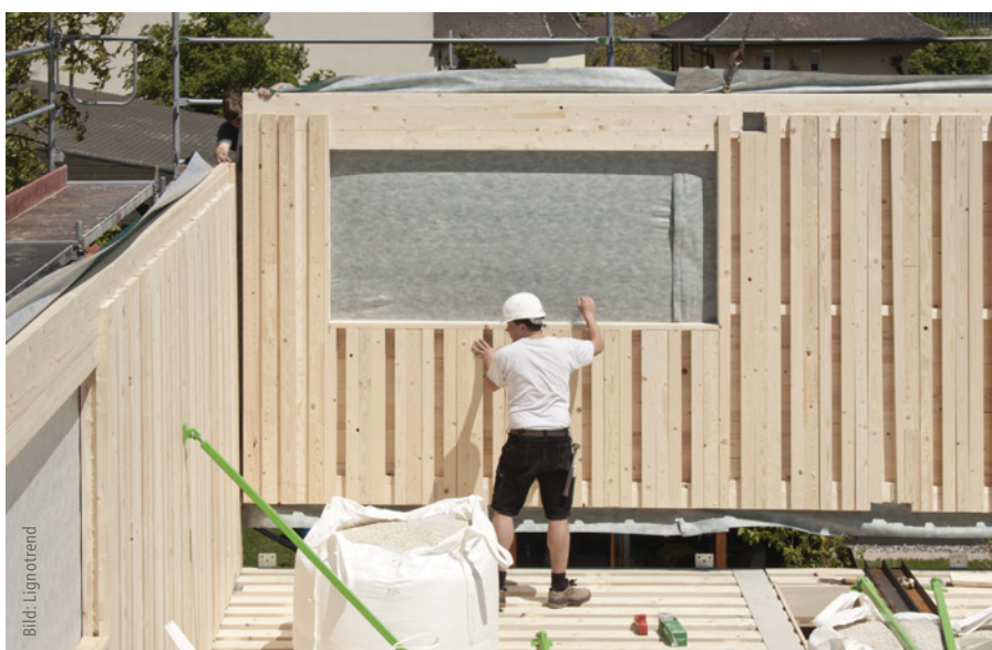
Schlankere Brettsperrholz-Rippenelemente im Einsatz als Wandbauteil mit Installationskanälen
