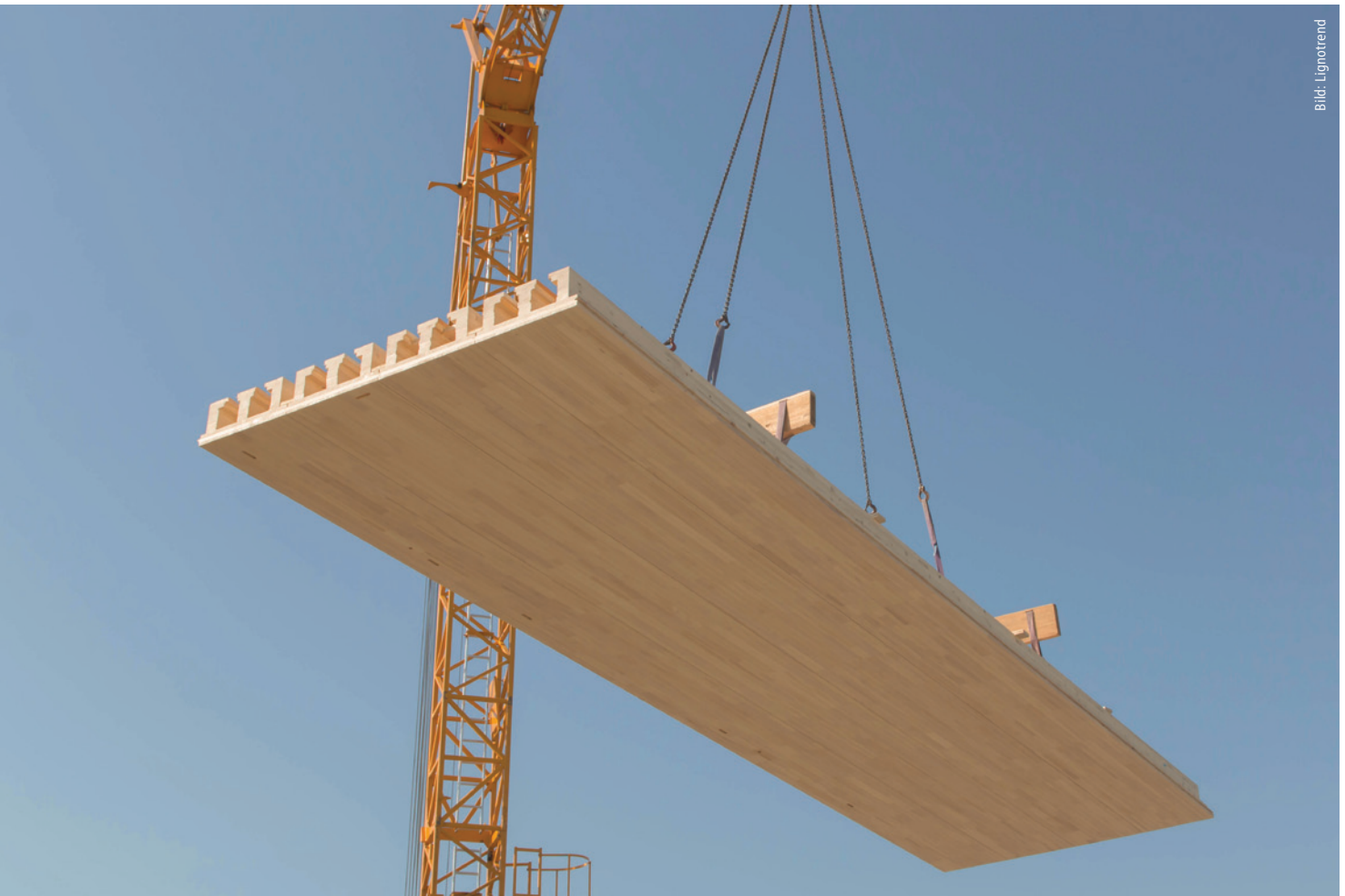
Montage eines großflächigen Rippendecken-Bauteils mit endfertiger Untersicht
