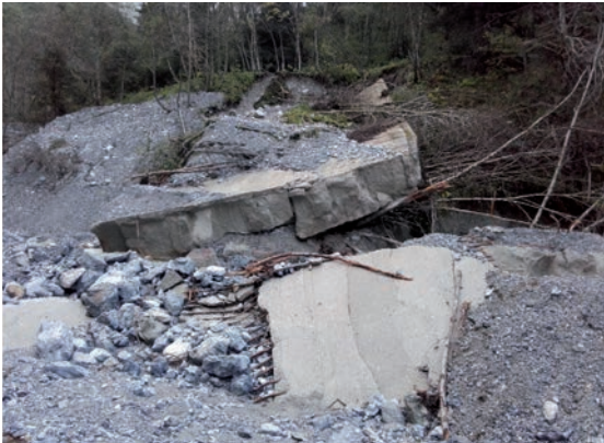
Bild 1: Zerstörte Sperre innerhalb eines Wildbaches in Tirol
