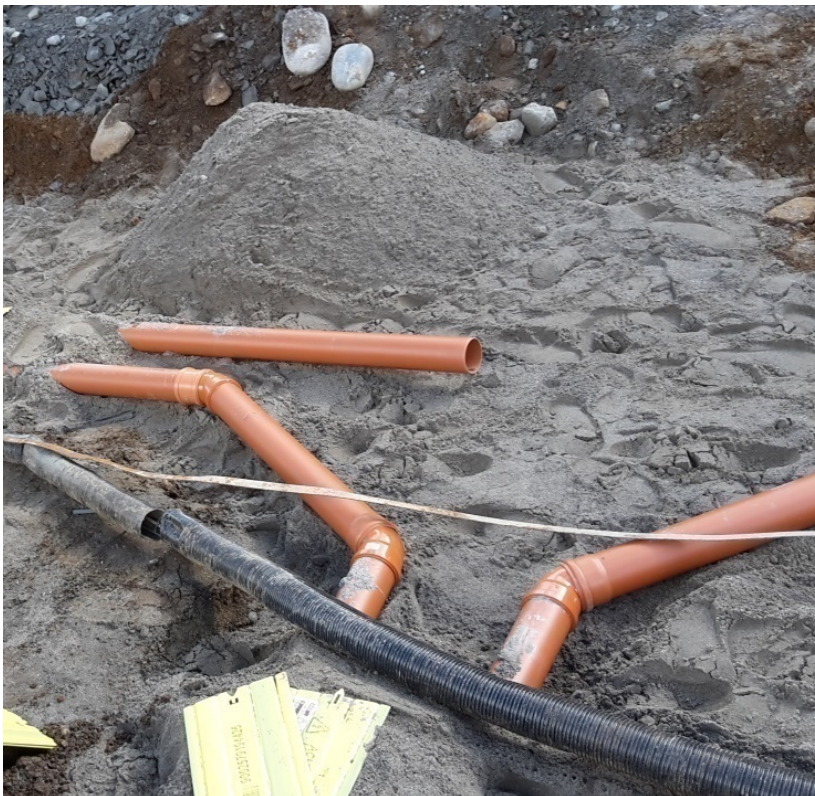
Links: Die alte Verkabelung der Messensorik (schwarzer Schlauch) und die Rohre für die Neuverlegung (rot); rechts: Die neue GPS Antenne der Universität Luxemburg
