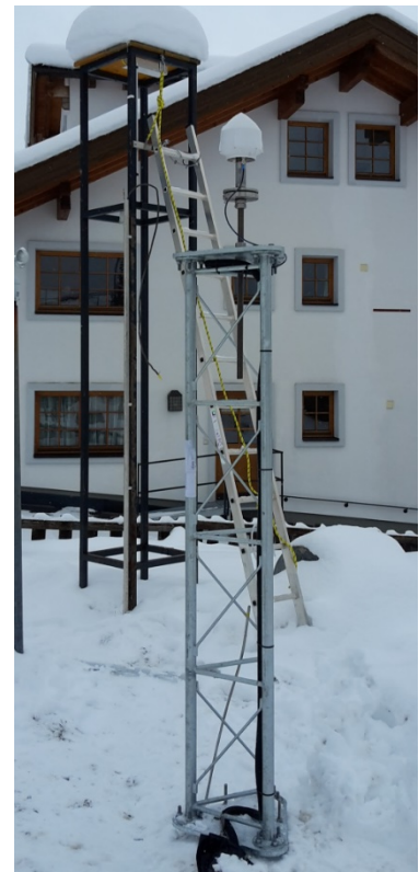
Links: Die alte Verkabelung der Messensorik (schwarzer Schlauch) und die Rohre für die Neuverlegung (rot); rechts: Die neue GPS Antenne der Universität Luxemburg
