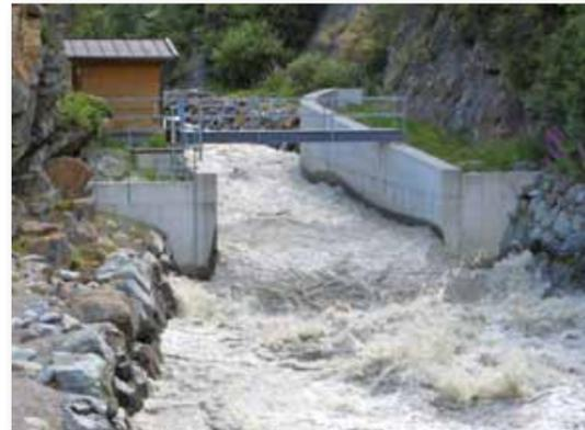
Die Pegelanlage Vent/Rofenache (in Seitental westlich von Obergurgl) im Jahre 2005 mit Pegelhäuschen, Messsteg und betoniertem Gerinne mit Einlauftrumpete im Oberwasser. Gemessen werden: Wasserstand, Oberflächengeschwindigkeit des Wassers, Wassertemperatur, Schwebstoff- und Geschiebetransport. Sämtliche Parameter werden kontinuierlich gemessen, vor Ort digital aufgezeichnet und mittels GPRS fernübertragen
